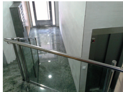
El mismo portal una vez dotado de acceso al ascensor desde nivel calle.
