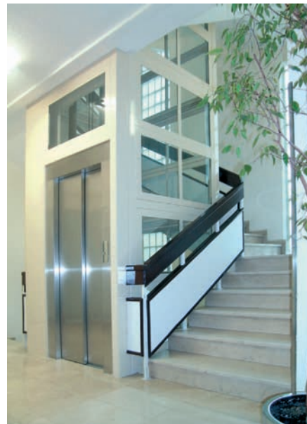
Edificio después de la instalación.
